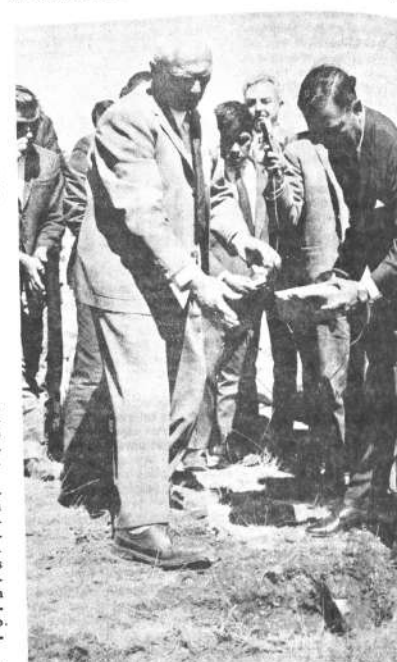
El Presidente Barrientos coloca la piedra fundadora del edificio donde se instalarán los estudios de la televisión.
