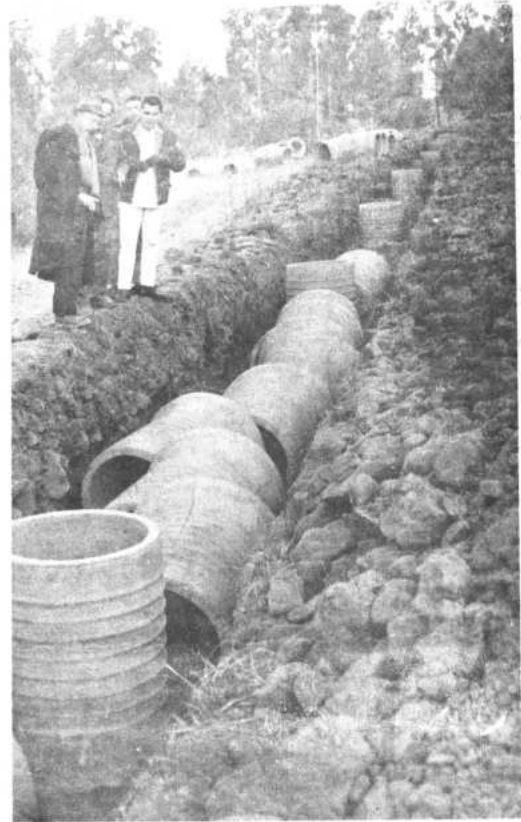
Aductor Tolapucru, Cala-Cala. 8,200 metros de tubería de cemento de 24 pulgadas, permitirá la conducción de 400 litros de agua por segundo. El H. Alcalde Municipal, Dr. Guzmán, inspecciona la obra en compañía de técnicos.
