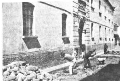
Trabajos que se realizan en la calle Oruro dentro de emergencia para el arreglo de baches en las calles. En la actualidad se está prestando el concurso para su adoquinado total con la instalación de fábrica de locetas de cemento.
