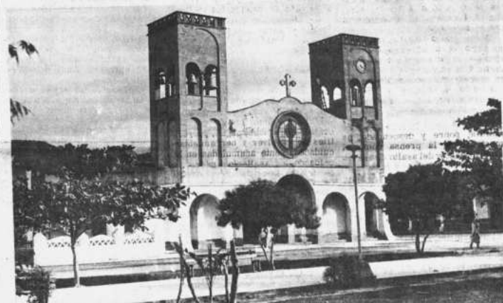
La típica iglesia de Santa Ana se yergue majestuosa en la plaza principal. Un pueblito en pleno corazón del Beni. Autoridades y habitantes están imbuidos de sanos propósitos en procura del progreso que se merece ese principal centro proveedor de carne vacuna. Celebra su fundación el 26 de julio de cada año.
