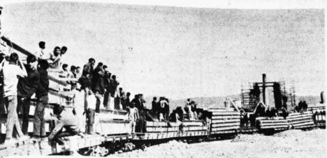
La foto muestra el momento en que llegaban a Vinto los vagones sobre los cuales vino la primera parte de la estructura metálica para la fundición de estaño. Esta partida que está en Vinto desde el sábado pasado ha comenzado ya a ser descargada.
