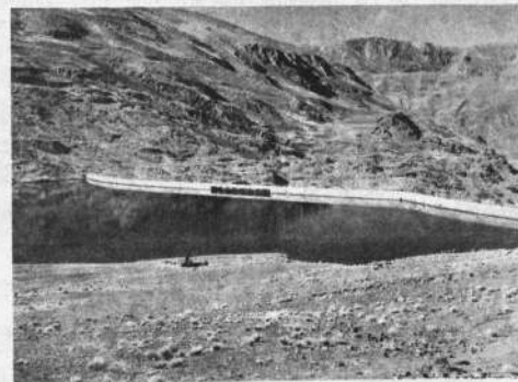
Trabajos en Hampaturi
