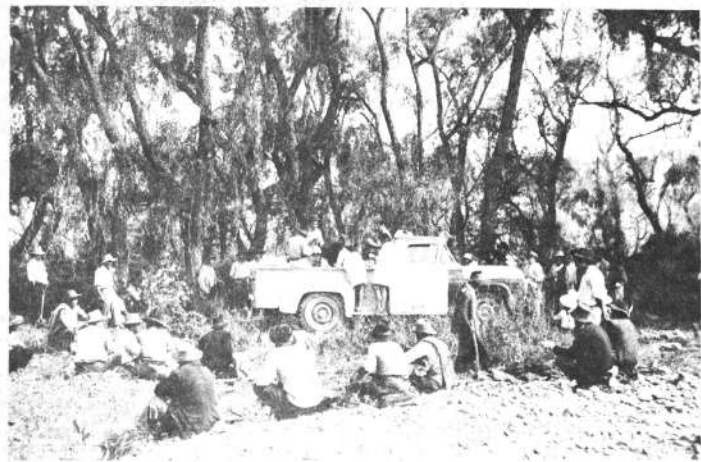
Distribución de alimentos a los trabajadores de "Vinto Chico", en la construcción de defensivos contra riadas, en Cochabamba.
