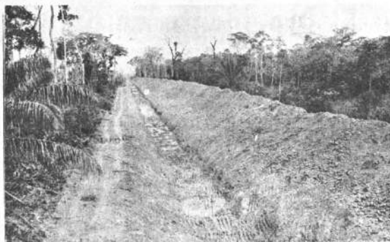
Santa Cruz, 12 (PRESENCIA). Canales de irrigación y de desagüe se construyen en diferentes zonas de la colonia de San Juan. Los primeros sirven para irrigar los terrenos carentes de agua, y los segundos, para habilitar las tierras cubiertas por aguas concentradas. Arriba el canal de desagüe del kilómetro 17 de 5.100 metros de largo para echar las aguas de lluvia al río Yapacani. En la jurisdicción de la colonia también funciona un moderno hospital.
