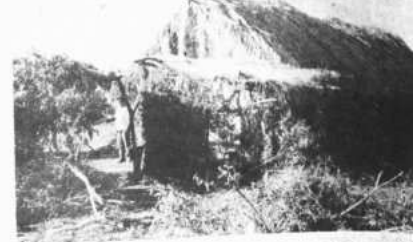
Este tipo de viviendas, construidas con hojas de motacú, con este centro apropiado para la anidación de vinchucas, eleva el porcentaje del mal de chagas. Igual peligro, ofrecen las viviendas viejas. (Foto NIKKA).
