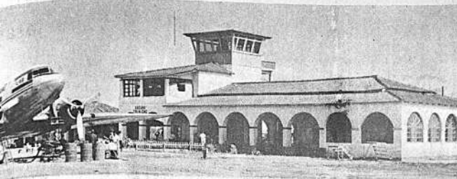
Este es el aeropuerto de Trinidad que AASANA recibió en próximas condiciones de conservación. Actualmente está siendo modernizado. La torre de control fue la que se construyó últimamente. La extensión de la pista será ampliada a 2.500 metros. Este aeropuerto ofrecerá un servicio más eficiente.
