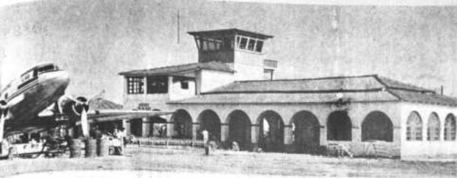
Este es el aeropuerto de Trinidad que AASANA recibió en pésimas condiciones de conservación. Actualmente está siendo modernizado. La torre de control fue lo que se construyó últimamente. La extensión de la pista será ampliada a 2.500 metros. Este aeropuerto ofrecerá un servicio más eficiente.
