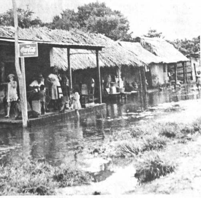
Las lluvias provocaron ingentes daños en el norte de Santa Cruz. Este es todo un barrio que, en febrero, apareció, como se ve en foto, casi completamente anegado.
