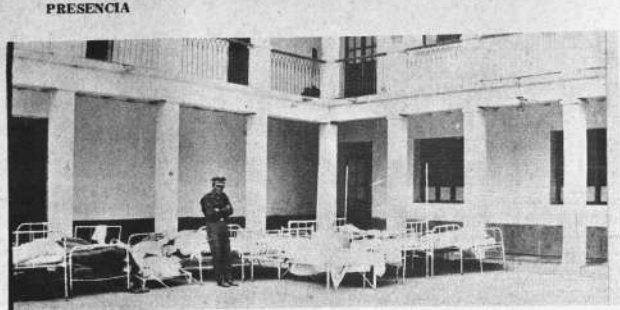
Un policía aparece junto a los catres que quedaron en buen estado después del derrumbe del techo del asilo “La Inmaculada”, donde estuvieron a punto de quedar aplastados.
