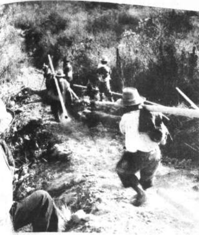
Los campesinos de Pojo, Cochabamba, mediante su esfuerzo propio están ayudando a los trabajos de captación de agua potable para dicha población.
