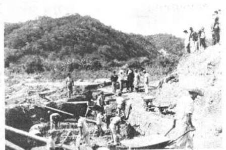
A un ritmo acelerado se están realizando los trabajos de reconstrucción del nuevo puente Tarumá sobre el río Piray, obra a cargo de la Empresa Barios y estará concluida en octubre próximo. (Foto PRESENCIA)
