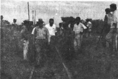
Santa Cruz, 25 (PRESENCIA).- A ritmo acelerado se viene realizando el trabajo de la nueva vía de comunicación férrea de Santa Cruz de la Sierra a Santa Rosa, en virtud del tratado bilateral suscrito entre los representantes oficiales de Bolivia y Argentina, el pasado año. La línea férrea, hasta el momento, ha llegado a la región de Vinu-Vinu, siendo posible que hasta fin de año ingrese a la importante población de Montero. Arriba, el ingeniero José A. Merelli, Subjefe de la Comisión Mixta Argentino-Boliviana, inspecciona el trabajo que desarrolla una de las empresas contratistas.
