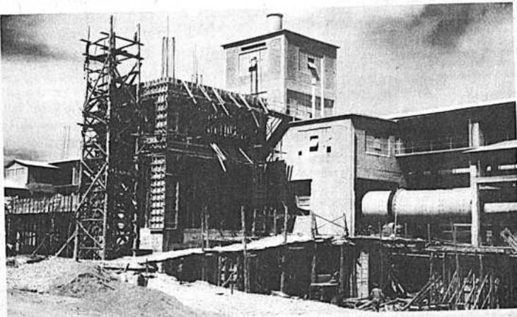
Soporte para horno e intercambiador de calor.
