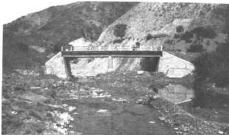
Puente Villazón, sobre el camino Sucre-Potosí Km. 10 + 500. Estructura de hormigón armado, 20 mts. luz total.
