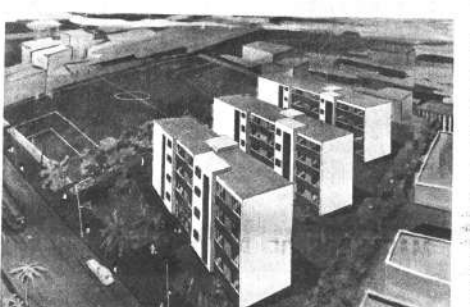
Edificios multifamiliares serán construidos por primera vez por CONAVI, dentro de sus programas habitacionales. La fotografía muestra los primeros tres edificios que se levantarán en la avenida Busch.
