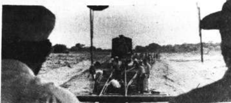
Punto de rieles en Viru Viru. Instalación de la segunda vía. La construcción del ferrocarril al norte de Santa Cruz avanza a pasos agigantados. Los trabajos se llevan a cabo bajo contrato, y tuvieron iniciación el 22 de Diciembre. Se ha fijado el término de dos años para la finalización a Santa Rosa, en el km. 102.-
