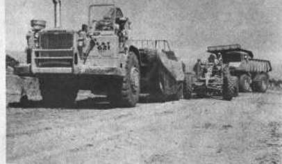
Equipo pesado que la empresa "Jones" utiliza en la construcción de los caminos de penetración del proyecto 1 y 4.
