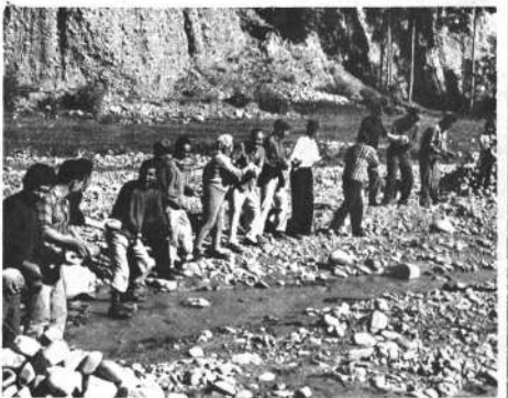
Vecinos del Bosque de Bolonia de esta ciudad, realizan cada domingo, en el río Irpavi, el amontonamiento de piedras para el empedrado del camino que une dicha urbanización con Bella Vista.
