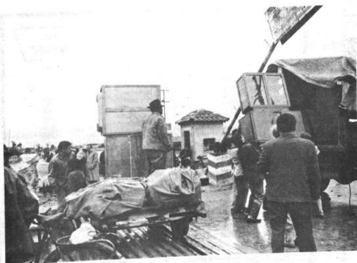
Familias enteras de las zonas afectadas por la inundación en Cochabamba, son evacuadas utilizando dicho sistema de locomoción. Cerca de tres mil personas resultaron damnificadas por las inundaciones. (Foto PRESENCIA)
