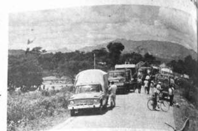
En el tramo Cochabamba-Santa Cruz columnas de motoristas impedidos de proseguir viaje, debido a las malas condiciones de la carretera. (Foto NIRKA)
