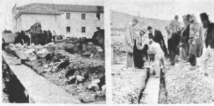
A la izquierda se aprecia el adelanto de los trabajos que se ejecutan en la región de Warisata, donde se inició la construcción de un comedor rural. A la derecha, personas del Ministerio de Asuntos Campesinos, inspeccionando la obra.
