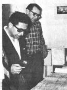
Los técnicos constructores del Centro Aduanero explican al Ministro de Economía (derecha) y el Subsecretario, Willy Vargas (izquierda) los planes de la obra que será entregada en febrero de 1969.
