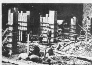
SE LEVANTAN LAS COLUMNAS DEL SHOPPING CENTER!!!
