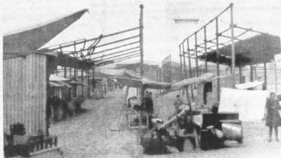
Una vista del Mercado "Bolívar". Los terrenos fueron adquiridos ante ágiles gestiones efectuadas por el H. Alcalde Municipal Julio Gonzáles Sanjinés, cuyo costo es de $b. 220.732.50, adjudicación que culminó en noviembre de 1967. Se estudia el financiamiento para la construcción de un moderno Mercado.
