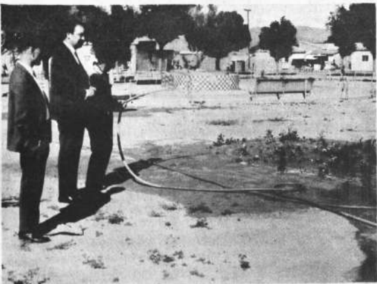
Una vista de la Avenida "Colombia" donde se cumplen trabajos interesantes por cuenta de la Municipalidad de Oruro. En este sector se cambiará el alumbrado eléctrico y habrán amplios jardines, labor que se realiza dentro los planes de embellecimiento de la ciudad.
