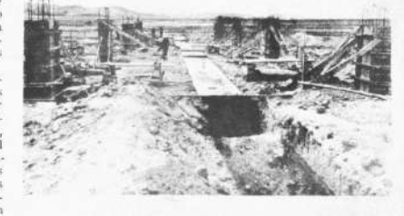
Concluidos los cimientos, se yerguen las columnas del departamento 300 de Química.
