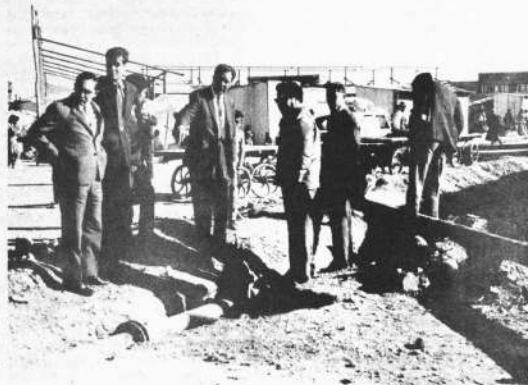
La Segunda Fase del Plan de Emergencia de Aguas Potables, se materializó para la Zona "Este". La labor del Jefe Comunal Julio Gonzáles Sanjinés fue pausable. La instalación de Pileas públicas en este sector permitirá superar definitivamente el problema del agua, con suministro del líquido elemento de Challapampita, mientras termine el Plan Global de la nueva Captación de Aguas Potables que está a cargo de la empresa constructora SVECA. Se estima que en octubre del presente año, Oruro podrá tener agua durante las 24 horas del día, felicidad para un pueblo, que sentía una enorme necesidad.
