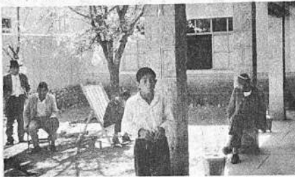
El pabellón de varones, donde los enfermos con TB, esperan su pronta rehabilitación que consiguen después de permanecer bajo estricta vigilancia médica por espacio de tres a cuatro meses.
