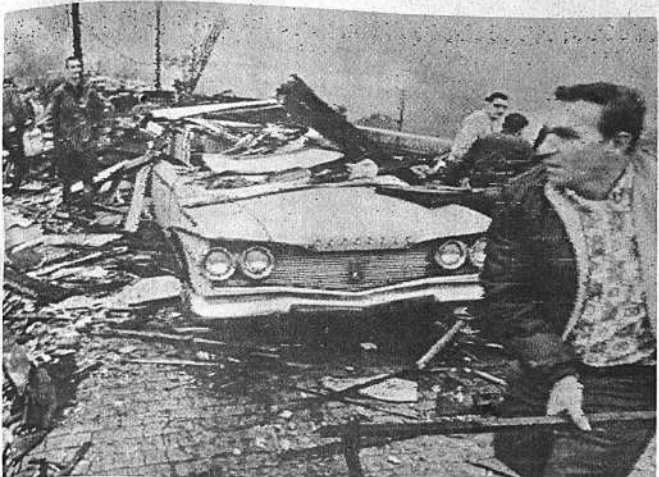
Pittsburg, 31 (AP).- Grupos de auxilio limpian escombros de una explosión en la suburbana Ingram, cerca de Pittsburg ayer, que hirió por lo menos a 16 personas. Se cree que la explosión fue provocada por un escape de gas. (AP RADIOFOTO).
