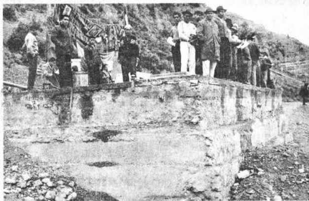
Vista parcial del estanque para agua potable que construyeron los vecinos de El Tejar y que fue puesto al servicio público el pasado domingo con asistencia de autoridades del Ministerio de Trabajo y de la H. Alcaldía Municipal de La Paz.
