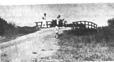
Puente sobre el arroyo "San Gregorio", construido con financiamiento prefectural y la cooperación de la mano de obra de las Juntas Vecinales de Trinidad.
