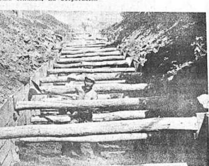
En una de las principales arterias de Santa Cruz, los trabajadores en plena actividad, ejecutando el alcantarillado de la ciudad. La conclusión de la primera etapa e inicios de la segunda costará 12.000.000 de pesos bolivianos. La finalización de la primera etapa comprende 11.000 metros de alcantarillado pluvial y cloacal.
