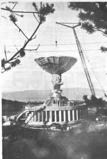
La estación "Orbita" se aloja en un edificio circular de hormigón armado, que al mismo tiempo sirve de base a la antena del sistema con reflector parabólico de 12 metros de diámetro.
