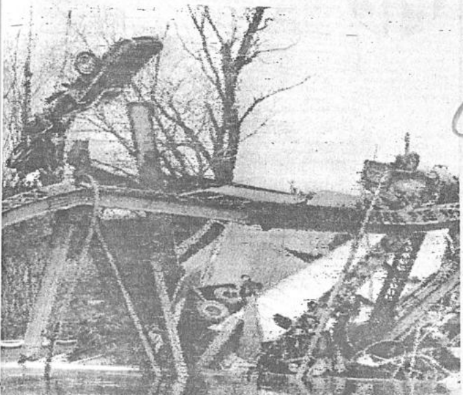
Gallipolis, Ohio, 17 (AP).- Una grúa eleva del río Ohio restos del puente, que se derrumbó, con partes de vehículos que cayeron al río. Un cadáver es visible en un auto. El puente que une a los estados norteamericanos de Ohio y Virginia Occidental se derrumbó el viernes. 75 vehículos cayeron al río.
