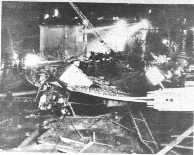
POINT PLEASANT, Virginia Occidental, 16 (AP).— Esta es la masa de automóviles, camiones y la estructura del puente colgante que quedó del Silver Bridge que se desplomó ayer al anochecer, en los aguas del Río Ohio. (RADIOFOTO AP).
