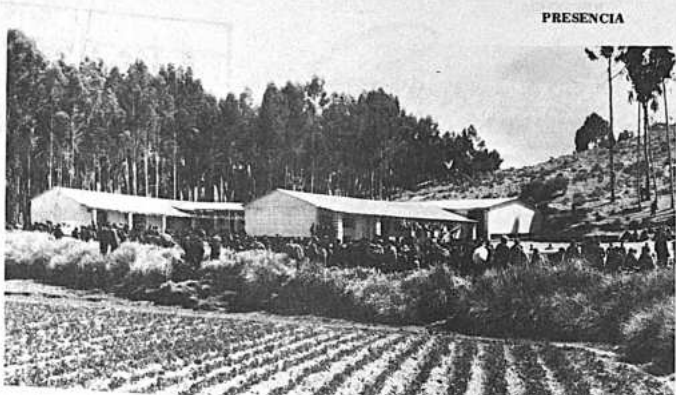
Este es el Colegio Mixto de Huatajata, que fue inaugurado por el Presidente de la República el sábado pasado. El establecimiento que fue construido por el sistema de auto-ayuda de Huatajata contribuyeron con el sesenta por ciento del costo total del colegio.
