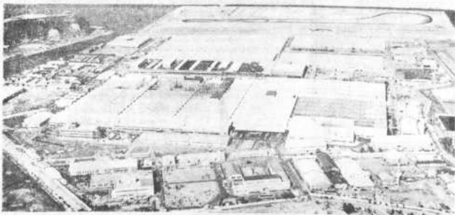
NISSAN OPPAMAN, planta de Kanagawa.
