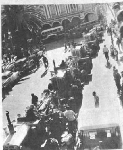
El Servicio de Caminos adquirió maquinaria pesada para realizar trabajos de reparación y construcción de las carreteras en el departamento de Cochabamba. Las niveladoras hicieron un recorrido por las principales calles de la ciudad. Aquí se las aprecia el momento en que pasan por la plaza 14 de Septiembre.
