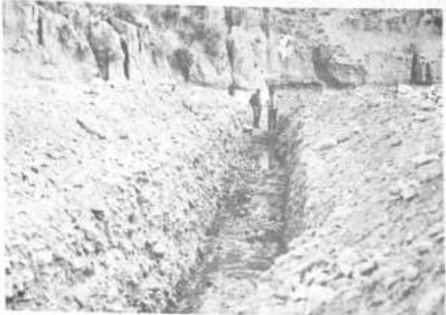
Asistidos técnicamente por la Dirección Nacional de Desarrollo de la Comunidad, del Ministerio de Agricultura, los campesinos de Huaraco, en la provincia Aroma de La Paz construyen una galería filtrante con la cual durante todo el año utilizarán aguas subterráneas del río Kaka para irrigar 25 hectáreas de tierras con un caudal máximo de 10 litros por segundo.
