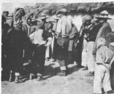
Campesinos toman acuerdos para hacer adobes para la construcción de la casa rural en Seryenoni.
