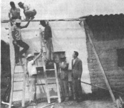
Construcción de la sede social donde funcionará la cooperativa de consumo, en Lagunillas - Vallegrande.
