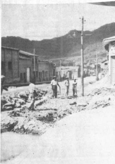
Cunetas cementadas están siendo construidas en las calles de Camiri.
