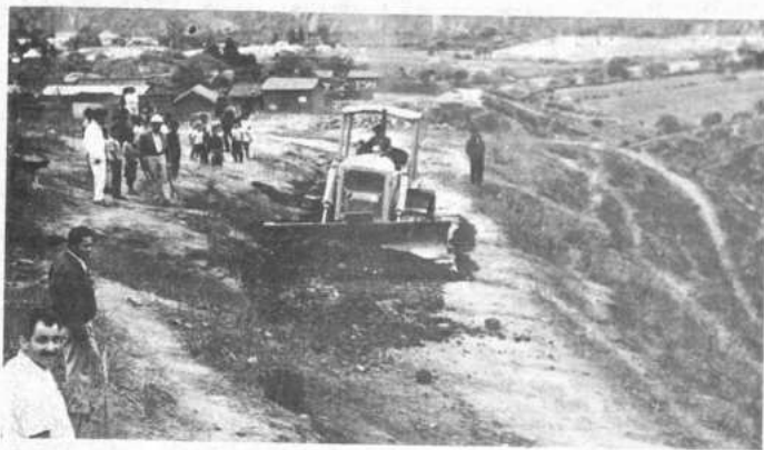
Construcción del camino que conducirá al nuevo Matadero ubicado en la zona sur de la ciudad. Esta obra está siendo ejecutada por Yacimientos, con cargo a regalías devengadas.
