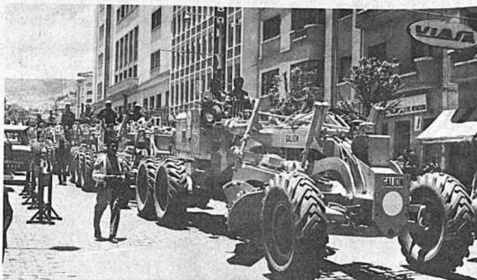
El Servicio Nacional de Caminos ha recibido una parte de la maquinaria que será puesta en servicio para la construcción y mantenimiento de las principales vías de comunicación en el país. En la fotografía se ve una partida de la maquinaria pesada formada por motoniveladoras, que entregó USAID con cargo al crédito de cinco millones de dólares otorgados al Servicio de Caminos. Ayer a mediodía, este equipo fue presentado al público en una exposición realizada en la Avenida Mariscal Santa Cruz.
