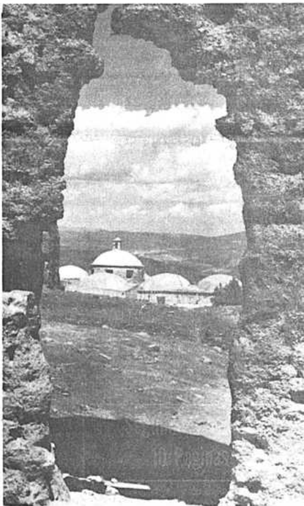
Desde un forado hecho por el tiempo a través de 400 años de historia, se distingue al fondo las cúpulas centenarios del templo de San Benito que hoy está bajo peligro de derrumbarse. (Foto Cima)
