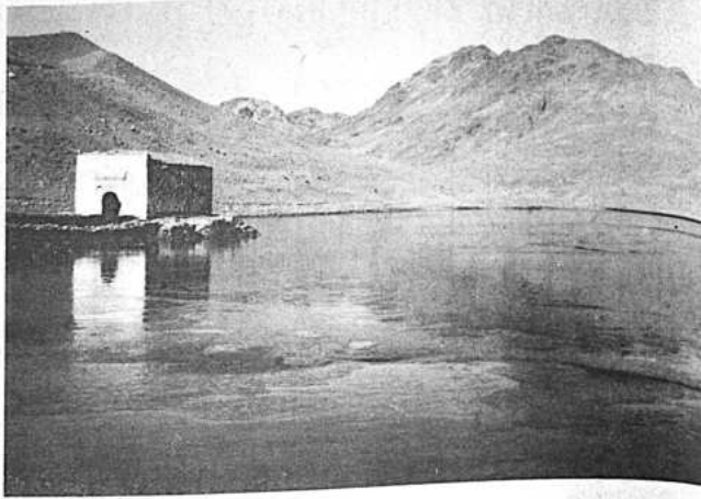
SAN SEBASTIAN.- Una de las 32 lagunas que los mitayos construyeron en la época colonial para la dirección de conquistadores, para mover ingenios y proveer agua a la población de Potosí que pasó de los 160.000 habitantes. (Foto Cima).
