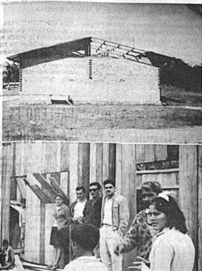
Centro de muy poco tiempo será concluida esta Escuela Seccional rural de la comunidad de "Abaroa de Azuzaqui". La obra se realizó con el esfuerzo de los padres de familia. En la foto de abajo se ve una parte de las viviendas para maestros construidas de madera ensamblada por los profesores y los padres de familia de la Escuela Central del Núcleo Escolar Campesino "Yapacani".
