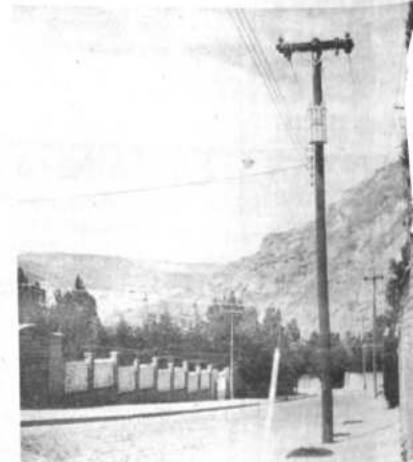
Ampliación del sistema de distribución en la ciudad con nuevas líneas y sub-estaciones, ofreciendo servicio seguro y eficiente.
