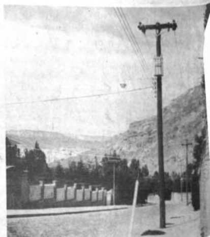
Ampliación del sistema de distribución en la ciudad con materiales, equipo y métodos nuevos, ofreciendo servicio seguro y eficiente.
