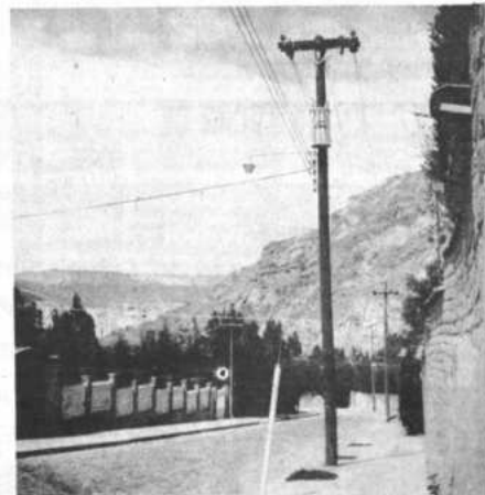
Ampliación del sistema de distribución en la ciudad con materiales, equipo y métodos nuevos, ofreciendo servicio seguro y eficiente.
