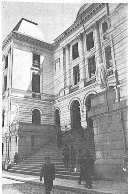
El Palacio de Justicia: por fuera, un estilo arquitectónico híbrido. Estatuas de piedra que representan la ley y el peso de la justicia; la espada y la lanza. Por dentro, oficinas que contrastan con la forma exterior del edificio; humedad, goteros, absoluta falta de comodidad y escasez completa de materiales de escritorio.
