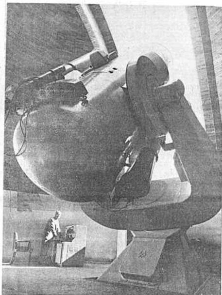
Observatorio astrofísico de Biurakan: Telescopio del sistema Schmidt, con espejo de un metro de diámetro.
