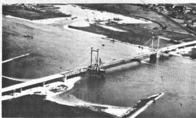
Aproximadamente un kilómetro de longitud tiene el nuevo puente entre Rees y Kalkar sobre el Rhin (República Federal de Alemania), que a fines de este mes será inaugurado y entregado al tráfico. El costo total asciende a 22 millones de marcos. El puente cuya anchura tiene 18,80 metros, está prevista para 4 calles.
