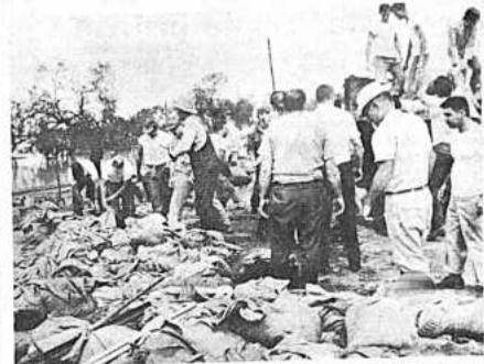
Voluntarios de McAllen, Texas, levantan pilas de sacos de arena para detener la inundación que amenaza como consecuencia del huracán Beulah que badejó sin techo a más de un millón de personas en México y Estados Unidos. (AP Wire photo)
