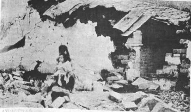
Sosteniendo a su hermanito herido, una niña aparece sentada frente a su casa completamente dañada, luego de que inundaciones y torrenciales lluvias azotaron la región de Salama, México. Las familias fueron evacuadas. (AP Wirephoto)
