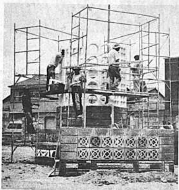
Obreros en plena labor construyendo uno de los stands, en la zona donde se realizará la Feria Exposición Industrial y Comercial de Cochabamba.
