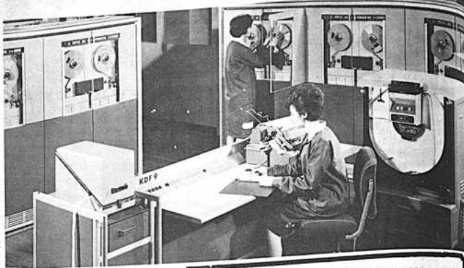
La sala de computadores en el Centro Meteorológico Británico, en Bracknell, cerca de Londres. Se están instalando cines para la predicción de las condiciones climatológicas por un computador al que se suministra datos acerca de la presión, temperatura y otros factores del clima recibidos de todas partes del mundo y de los satélites.
